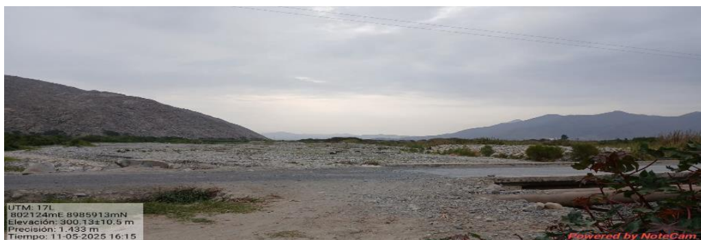
FIGURA N°03: EN ESTE TRAMO DEL SECTOR PUENTE COLORAO - COCHARCAS, EL CAUCE DEL RÍO NEPEÑA, SE ENCUENTRA COLMATADO.
